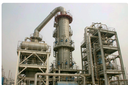
石油化工与炼油 Petrochemical & refining 316L · 825 + SA516 Gr.70
